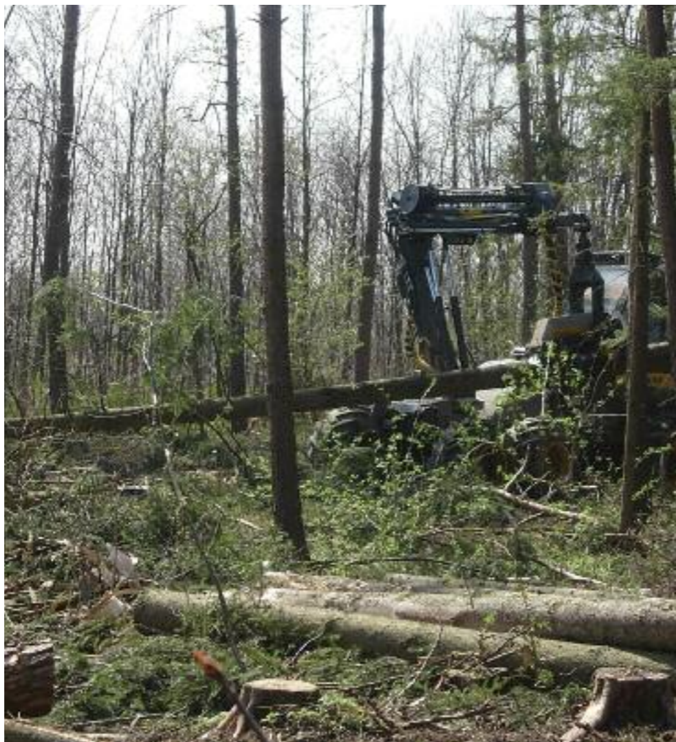
April 2007: Die Rodung für das Kraftwerk beginnt
