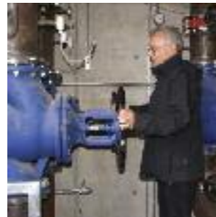
Bürgermeister Dr. Klaus Bühler öffnet den Schieber: Die Wärmelieferung der Gemeinde an die Firma HILTI beginnt
