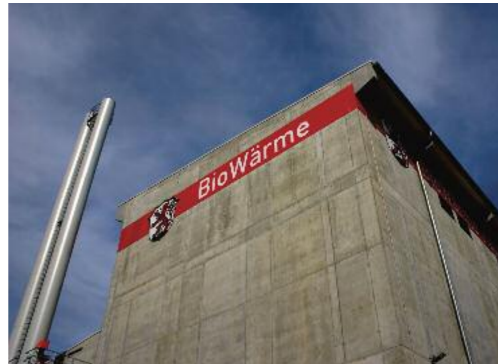
Industriebau Heizkraftwerk - Funktionalität und Wirtschaftlichkeit im Vordergrund
